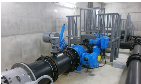
図 5.3.2 緊急遮断弁
