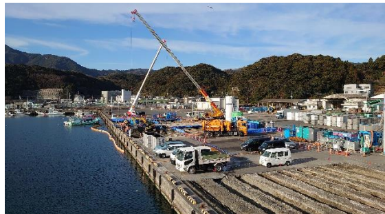
北浦漁港 荷さばき施設整備
