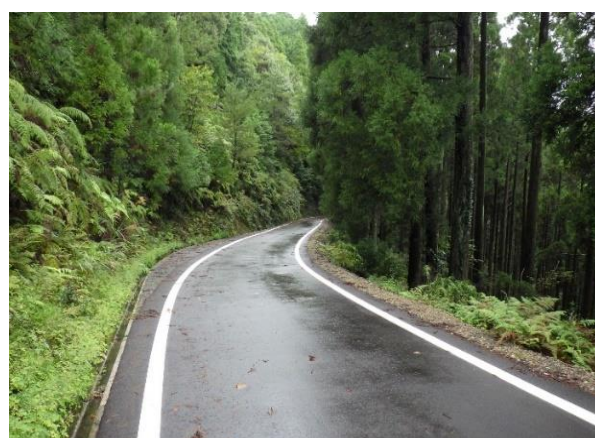
林道の舗装整備が進む俵野・黒原線（北川）
