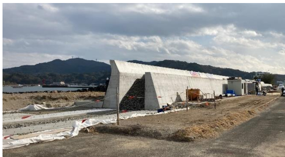
土々呂漁港 東浜地区防護岸整備
