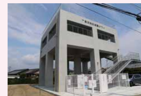
長浜町避難タワー（津波避難ビル）
