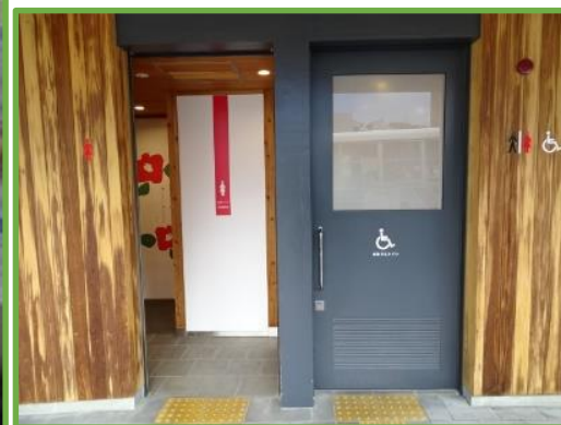
女子トイレ（大3） 多目的トイレ
