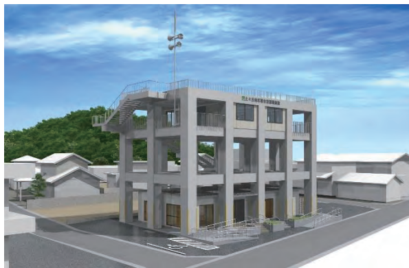
土々呂地区複合型津波避難施設
