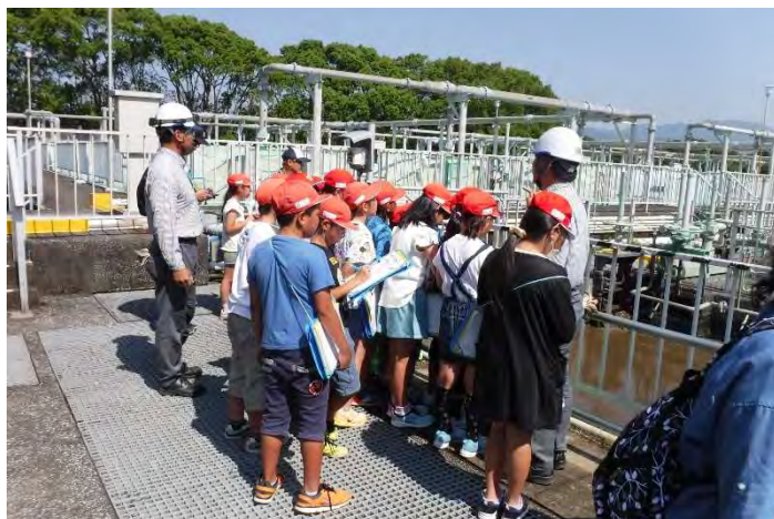
「処理場見学会」の様子(妙田下水処理場)
