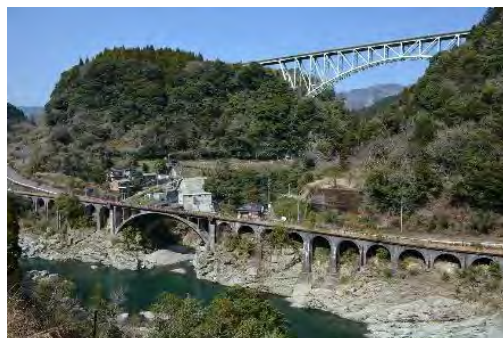
国指定重要文化財 「旧綱ノ瀬橋梁」
