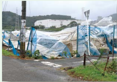
令和元年 9 月（台風 17 号）の夏田町の竜巻被害
