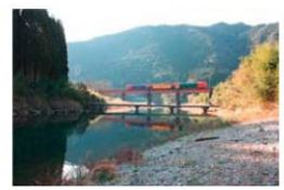
104.北川町深瀬橋
