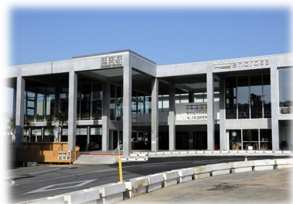
駅前複合施設 エンクロス
