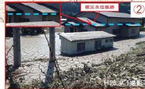
浸水解消後の流入土砂堆積状況
