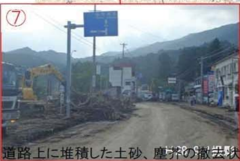
道路上に堆積した土砂、塵芥の撤去状況
