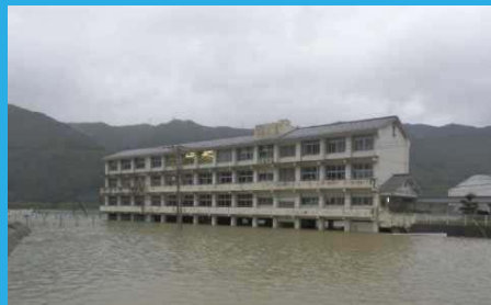
徳島県 阿南市 那賀川水系の浸水状況
