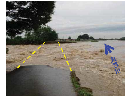
被災状況(拡大写真)
