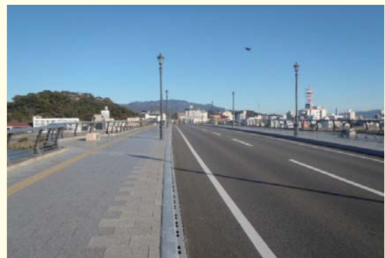
亀井通線（大瀬橋）
