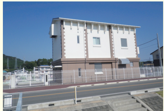
岡富古川ポンプ場
