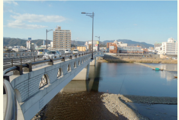
景観に配慮した公共施設（安賀多橋）
