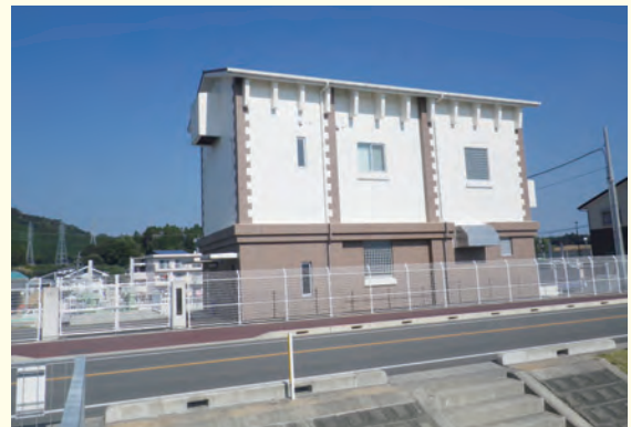
岡富古川ポンプ場
