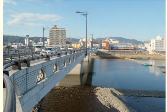
景観に配慮した公共施設（安賀多橋）
