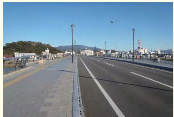
亀井通線（大瀬橋）
