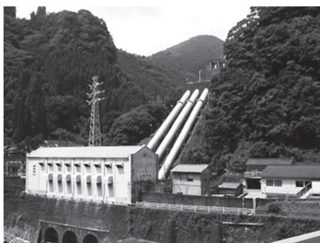
五ヶ瀬川水力発電所
