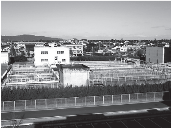
一ヶ岡下水処理場
