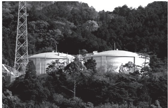
耐震化された古城配水池
