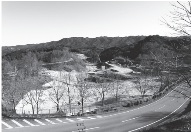
建設中の新最終処分場
