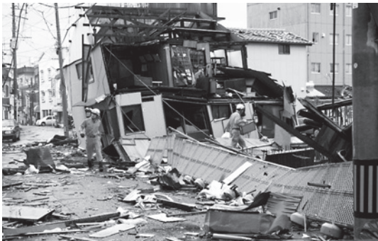
竜巻での被災状況(栄町)
