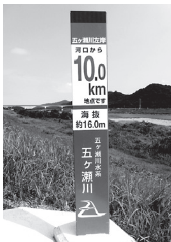
国交省設置の海拔表示板
