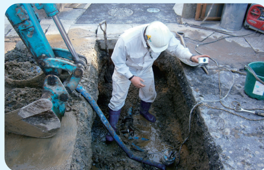
応急復旧状況
