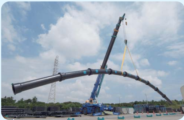
耐震管の吊上げ状況
