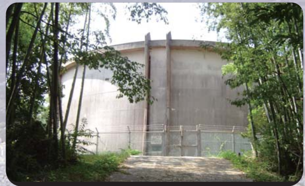
配水池の状況
