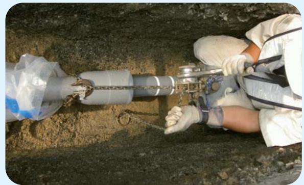
配水管(耐震管)布設状況
