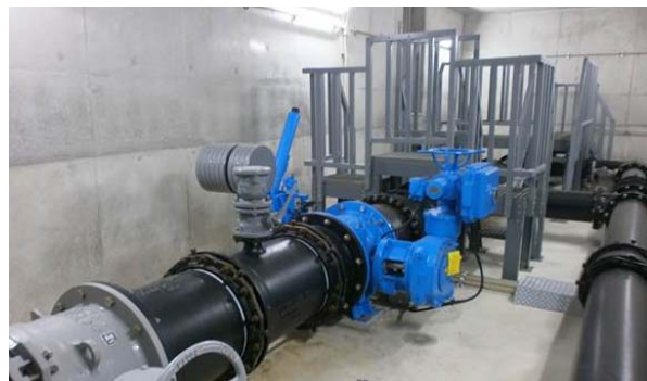
写真 5-4 緊急遮断弁
