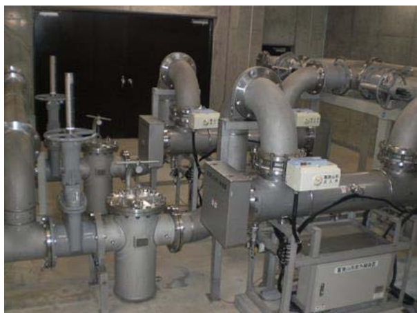
写真 5-1 紫外線処理設備（祝子）
