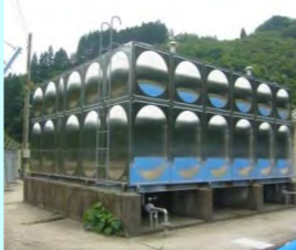
新設された多良田配水池
