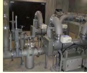
写真：紫外線処理設備（祝子）
