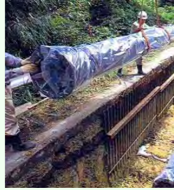
ポリスリーブ被覆による腐食対策
