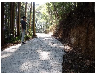
(コンクリート路面工 完成)
