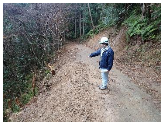
(路肩補修 完成)
