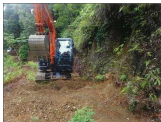
(路肩補修 着手前)
