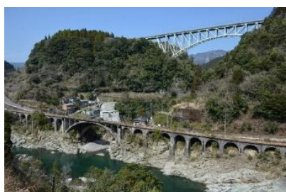
国指定重要文化財 「旧綱ノ瀬橋梁」
