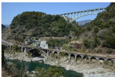
国指定重要文化財 「旧綱ノ瀬橋梁」
