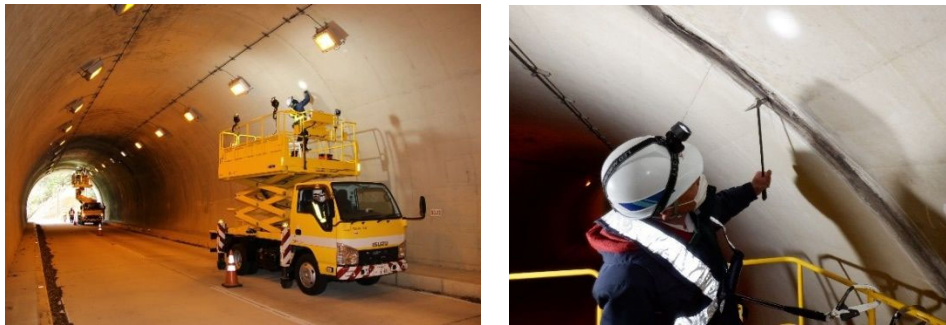
写真 2.1 定期点検状況
