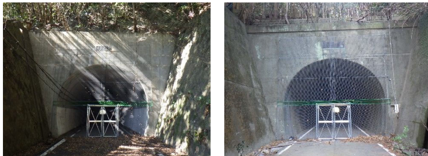
写真 2.2 廃止隧道における対応（左：須美江隧道、右：下阿蘇隧道）
