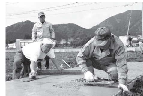
稲葉崎地区の作業風景
