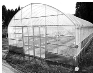
1アールハウス外観
