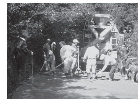
下三輪地区の作業風景
