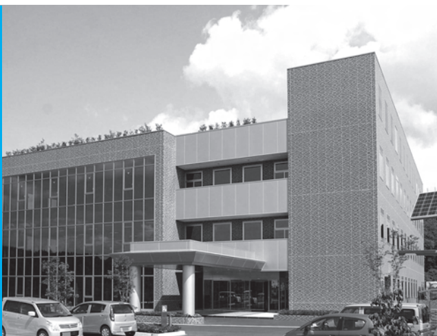
工業団地第1工区にオフィスビル完成
