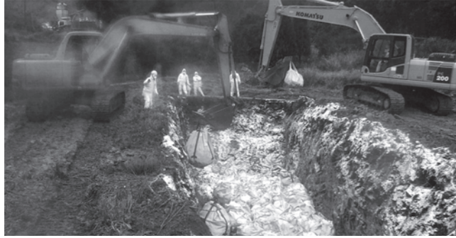
北浦町で行われた埋却作業の様子
