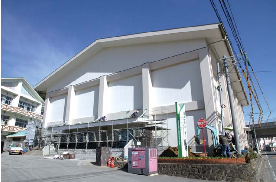
間もなく完成する東海中学校の体育館。新しい施設で卒業式を迎えられる
