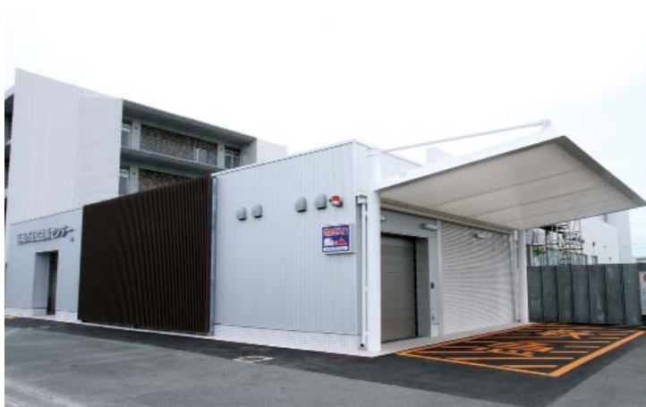
増改築中の夜間急病センター 救急車専用の出入り口も改修
