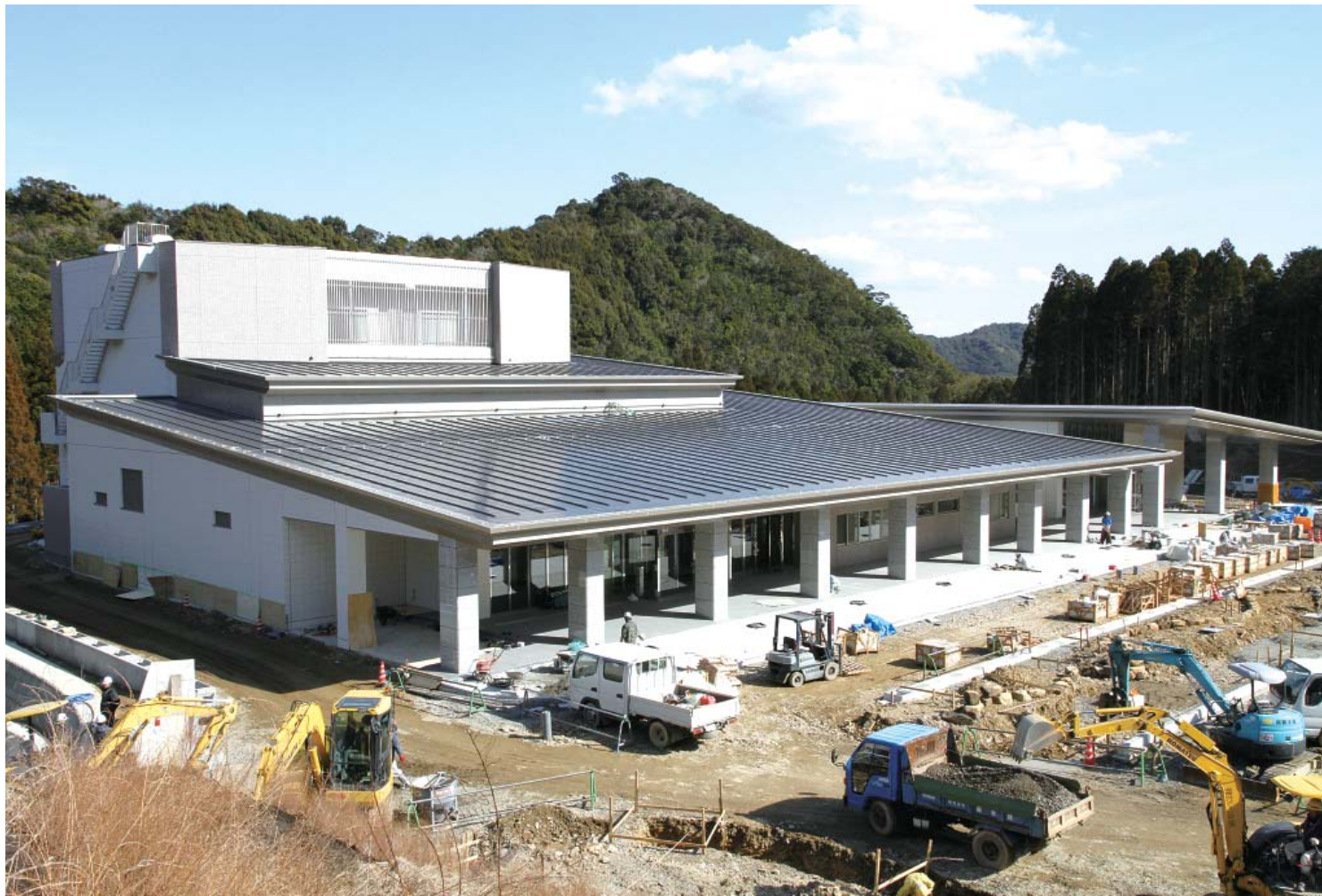
4月1日の開館に向けて、急ピッチで工事が進められている延岡市斎場「いのちの杜」
