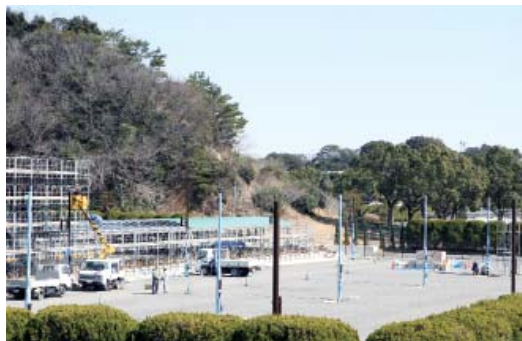
工事中の西階テニスコート。大会運営棟の建設も進む
