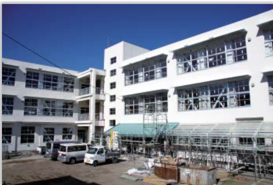
※延岡西小学校 耐震化工事
