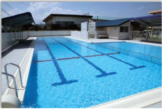
改築した方財小学校 プール
