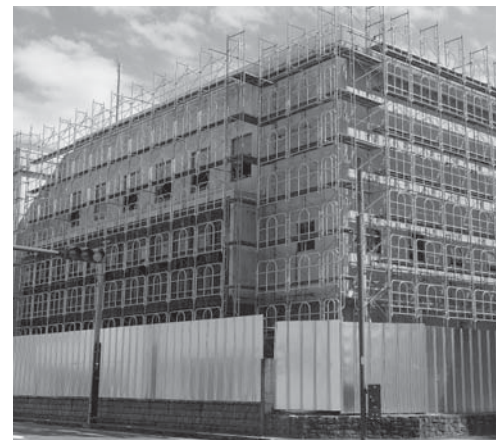
解体工事が始まった旧庁舎
