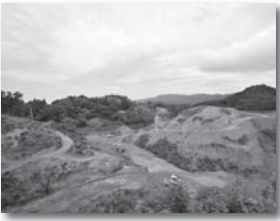
新最終処分場 建設地
