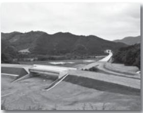
高速道路建設現場
