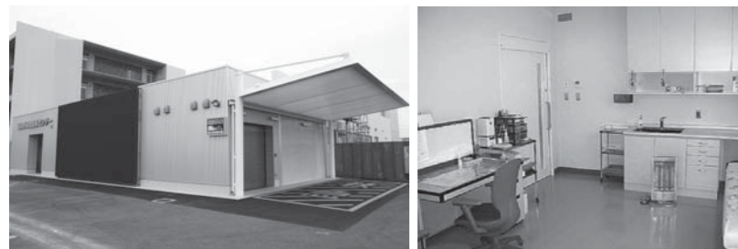
増築された夜間急病センター
