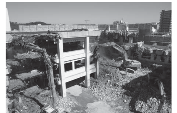
現在解体中の旧庁舎
