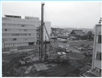
新庁舎建設地について、大規模な地震発生時においても液状化等の影響を受けない地盤とするため、「砂杭工法」による地盤改良工事を行いました。
