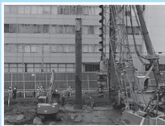
この工事では、岩盤まで掘削した穴に、基礎杭を埋設していきます。高層棟の建設工事においては、160か所に基礎杭を埋設することになります。基礎杭工事の完了後、8月上旬から、基礎工事に着手し、今年度中には3階部分までの躯体工事が完了する予定です。
