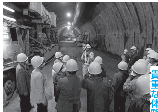
トンネル工事現場で
