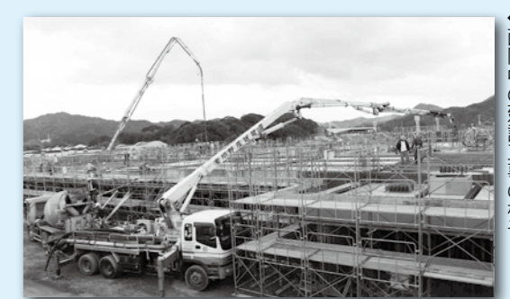
◆西階中の建設工事の様子
