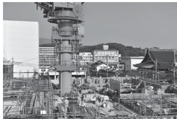
新庁舎建設作業現場
