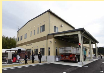
新最終処分場 (北方町笠下地区)
