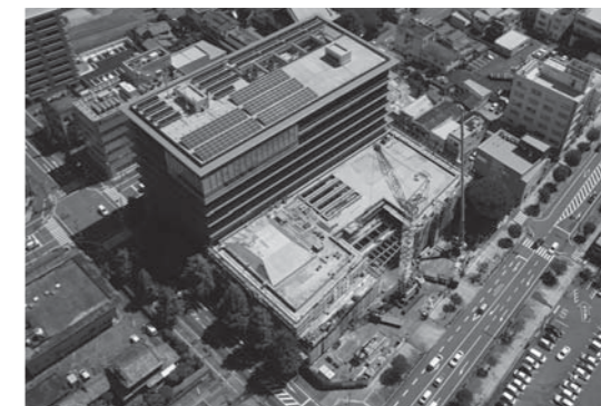
建物の構造体ができ上がりました (今年6月撮影)
