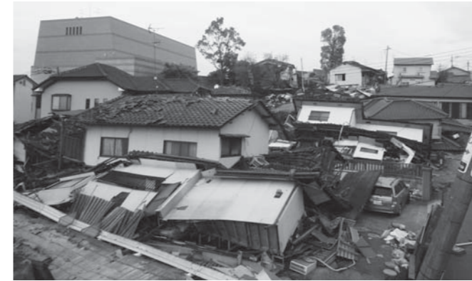
熊本地震で被災した住宅
