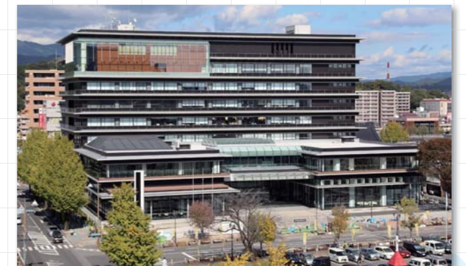
▲ 平成25年5月から建設を進めていた、延岡市役所新庁舎が完成。新庁舎では1階と2階に窓口部門を集約し、市民サービスの向上を図ったほか、市民スペースやレストランなど市民の皆さんがくつろげるスペースを設けています。
