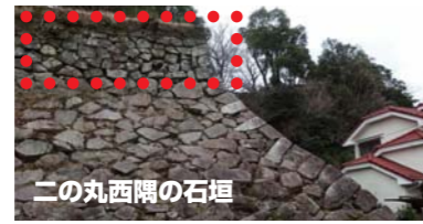
二の丸西側の石垣 上部と下部で積み方が異なる石垣は、城の構築や修復時期を知る手がかりとなる
