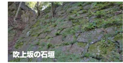
吹上坂の石垣 「見せる石垣」として表面を丁寧に整え「布目積み」技法で築かれている
