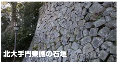
北大手門東側の石垣 緩やかな反りを持ち「算木積み」技法で築かれている
