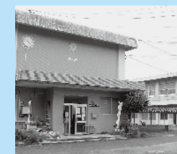
旧北方小学校体育館
