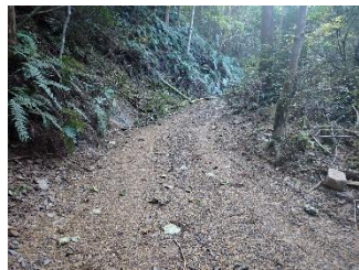
(路面整備 完成)
