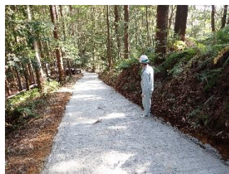
(コンクリート路面工 完成)
