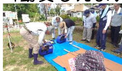
【発動発電機の起動】
