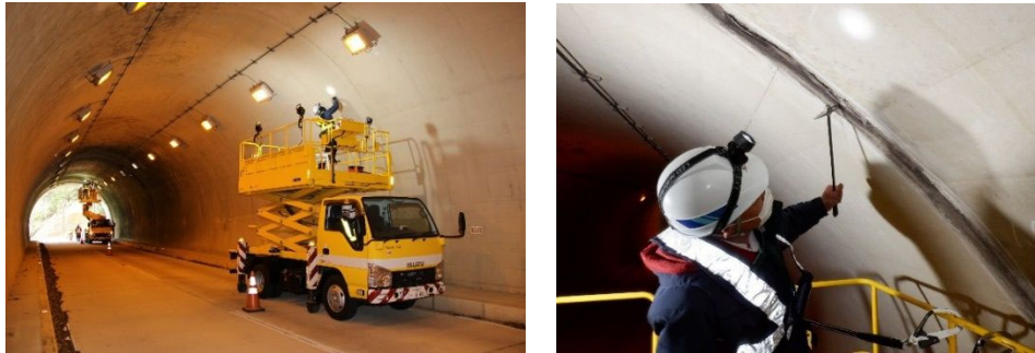
写真 2.1 定期点検状況
