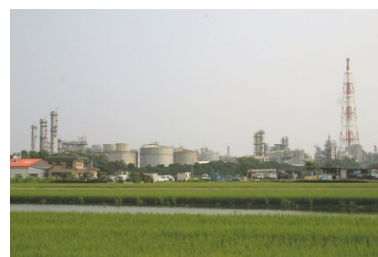
長浜町の工場
