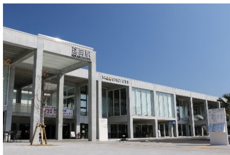
延岡市駅前複合施設エンクロス
