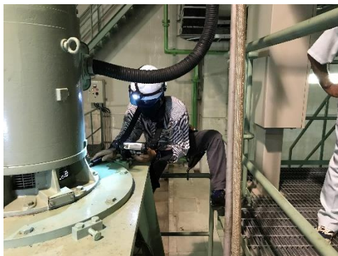
ポンプの振動測定状況
