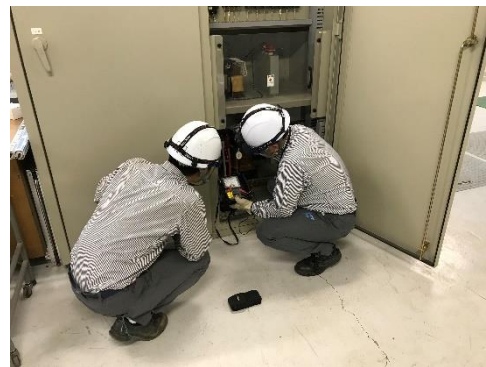
電気の絶縁抵抗測定状況
