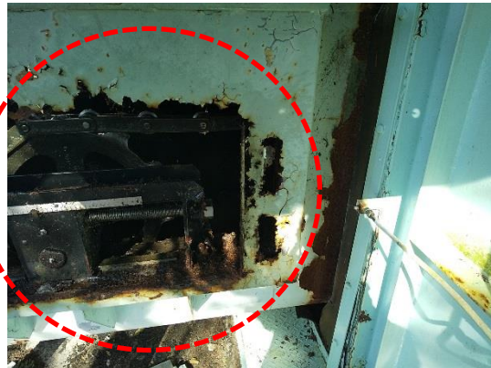
中島町ポンプ場 沈砂池設備 沈砂搬出機の腐食による破損
