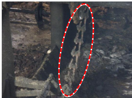
妙田下水処理場 最終沈殿池 汚泥掻き寄せ機チェーンの破断
