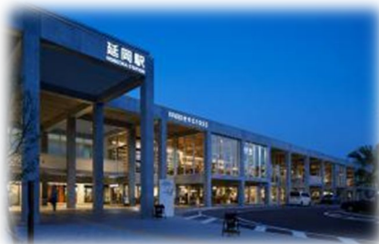
延岡市駅前複合施設 エンクロス
