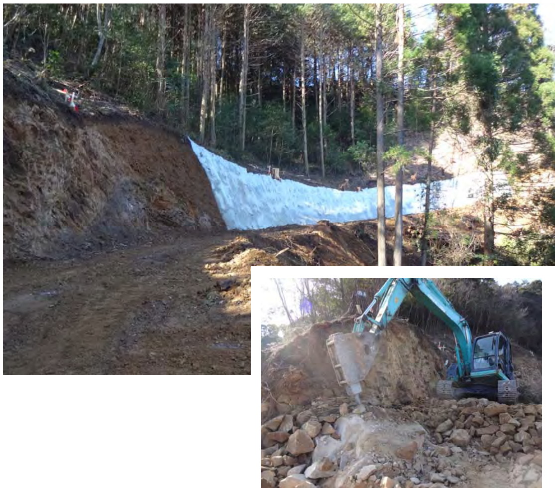
（開設中の林業専用道）
