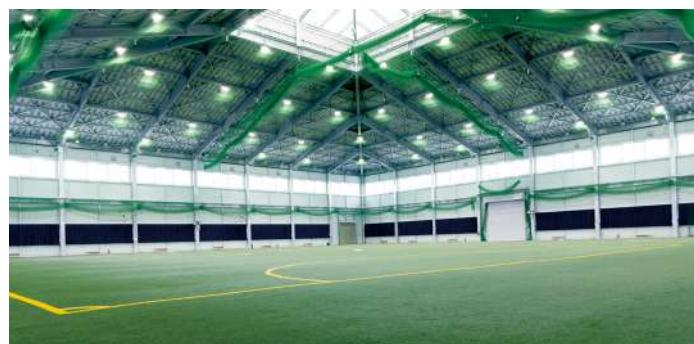
アリーナ内の通路には延岡産材（ヒノキ）のベンチを設置しており、利用者の休憩や競技の観覧に利用できます。床面には人工芝、屋内四隅に給水可能な洗い場を設置。天井部のLED 照明のほか、各所に配置された窓と天井中央部の白幕により、多くの自然光を屋内に取り込みます。また、内部の温度上昇を抑える効率的空気循環機能を備え、快適な環境を整えています。
