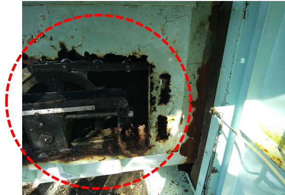
中島町ポンプ場 沈砂池設備 沈砂搬出機の腐食による破損
