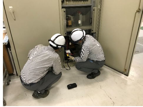
電気の絶縁抵抗測定状況
